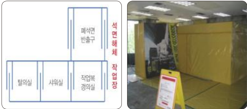
[그림 30] 석면폐기물 반출구 설치 예시
