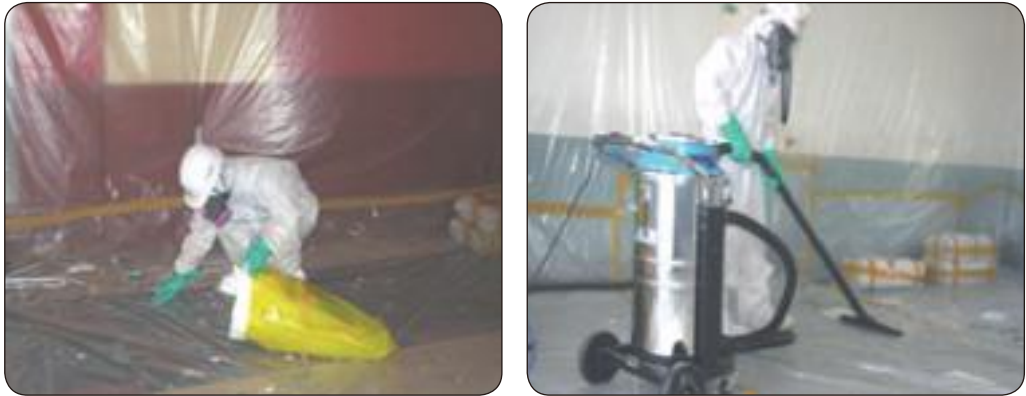
[그림 28] 석면함유 잔재물의 청소 모습
