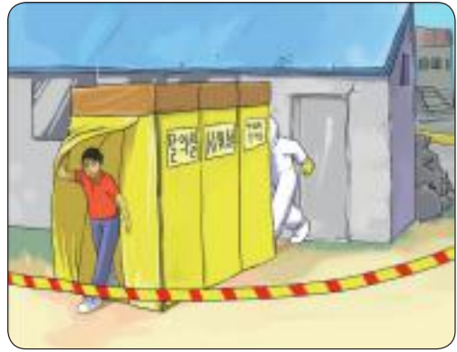
[그림 14] 해체·제거작업 인근에 설치된 위생설비
