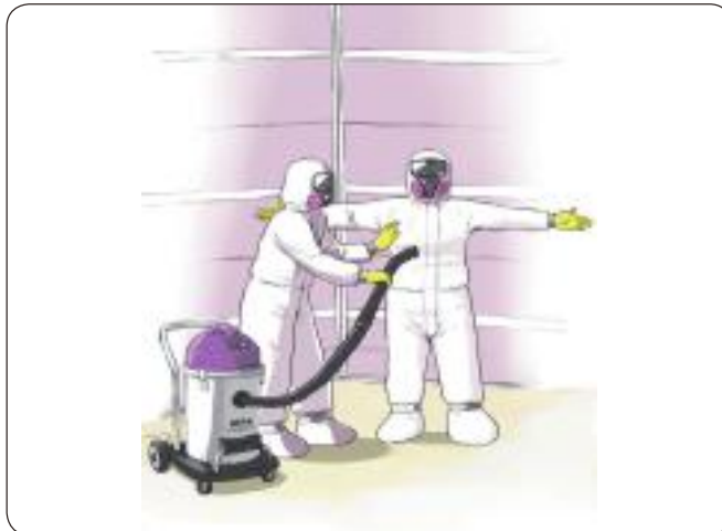
[그림 15] 작업장 이동 전 석면분진 세척모습
